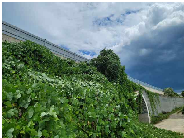
주변영향인자(성토부, 상부 본선) 상태현황
