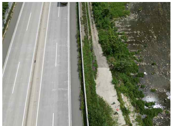
주변영향인자(성토부, 상부 본선) 상태현황
